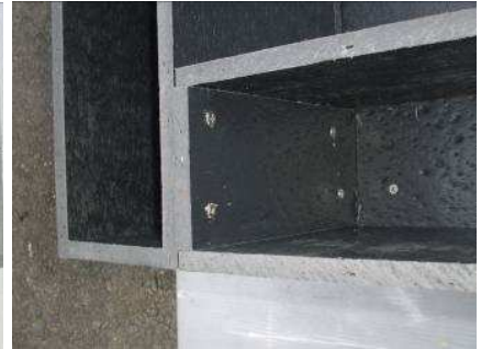
枕木コの字に沿わせて、次の枕木コの字を 載せ、側板をビスどめする
