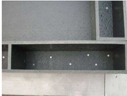
枕木 コの字 をビスで底板に打ち付ける 約 10cm ピッチ(千鳥)
