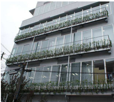
大阪市 商業ビル L14,000 x W180 x H340mm (L1.8m x 8 基連続 3段設置)
