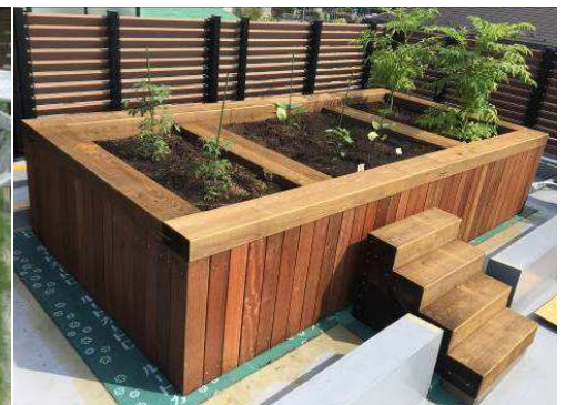
世田谷区成城個人邸 杭木・デッキ材張り仕上げ W1,700 x L3,850 x H700mm
