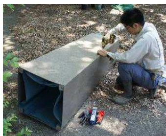
ボード 4mm+ 45×180cm に 角材 44×44mm を接着&ビス止め
