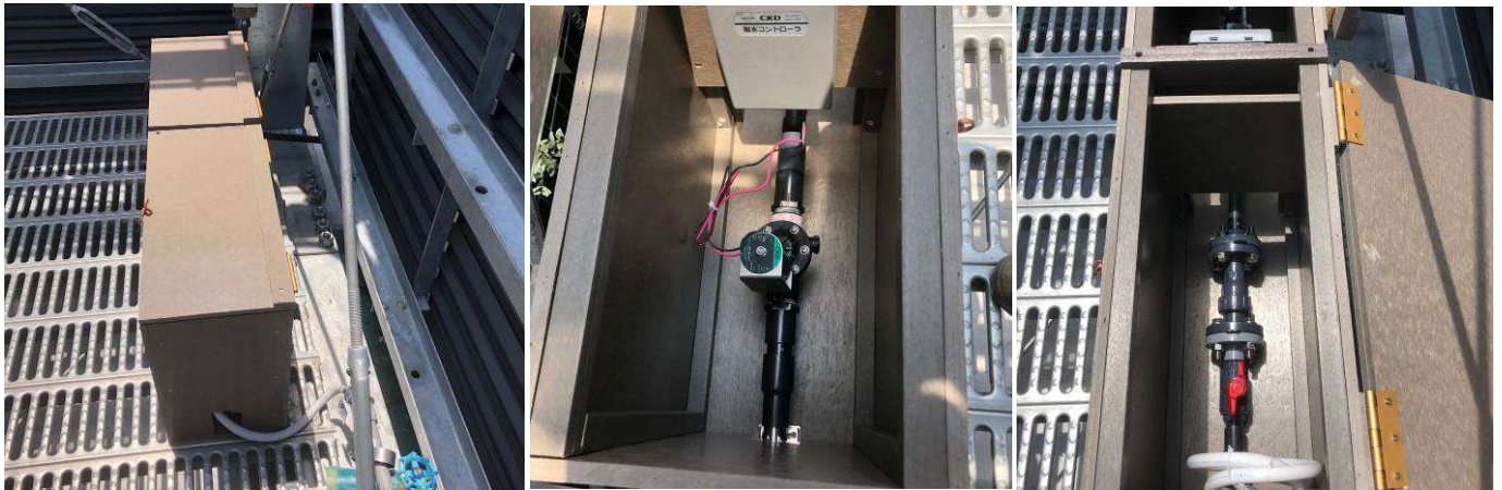
電磁弁・電池式コントローラー・ボールバルフ・チャッキバルフを内臓したカバー 蝶番開閉式加工品
