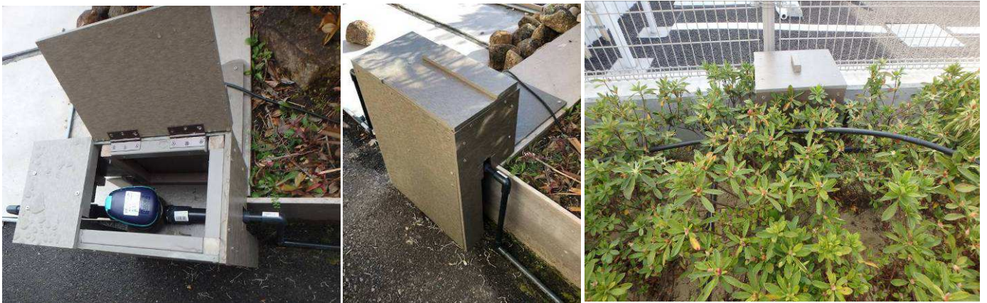
電磁弁一体型シンカーDC7E 高床式リフrafコントローラーカバー 蝶番式加工品
