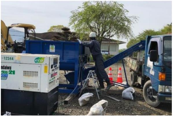
混合物(エコミックス)をコンベアでダンプに積載
