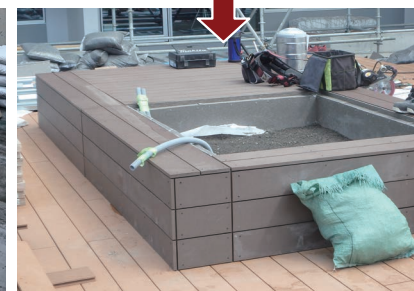
骨材はリプラ角材を使用しデッキ材張付け
