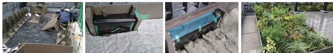
周囲枠設置→防根シート敷設 防根シートの上に排水DM敷設 排水DMの上にGRを敷く 草本・低木植栽仕上がり
