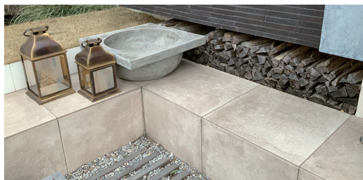
EPSにモルタル・コーティング・左官仕上げしたベンチ
