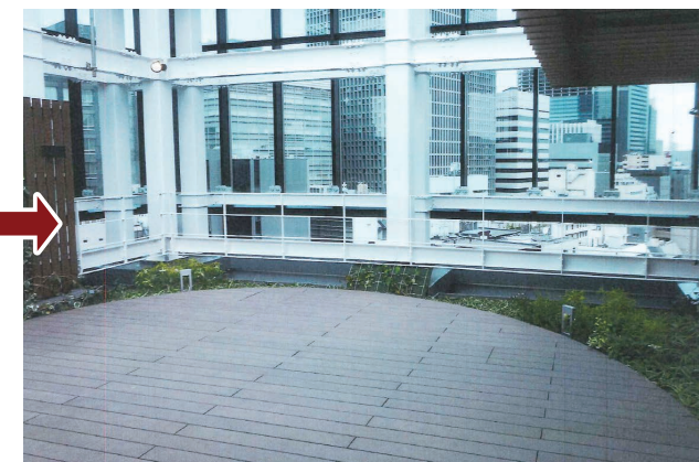
東京都中央区 屋上庭園
