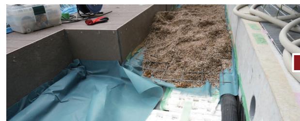
デッキ下 立上げ壁 深さ36cm
