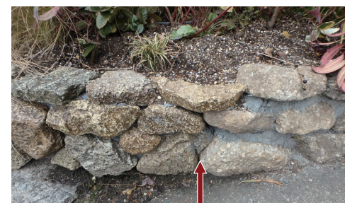
本物石と擬岩の石積み 隙間に切断擬岩はめ込み
