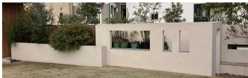
EPS壁(フェンス)
