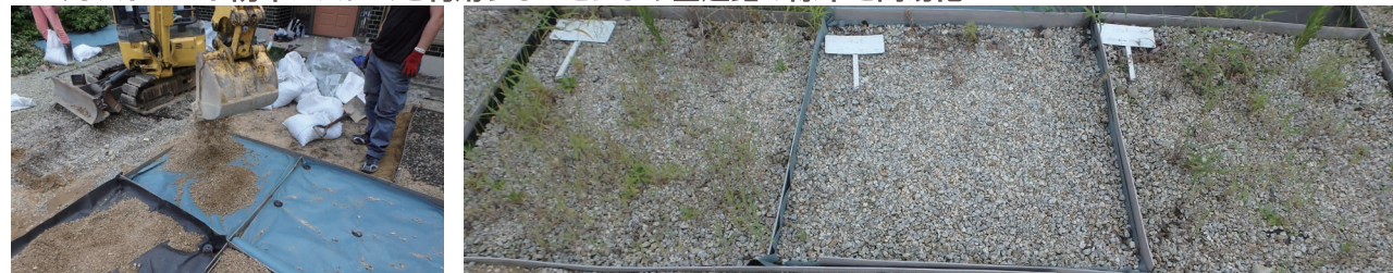
くるストシートに砂利を被せる
