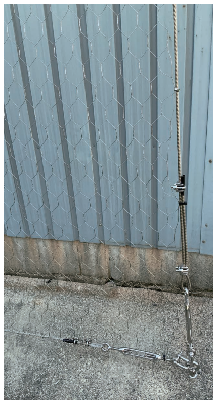
亀甲網・ワイヤー・タンバクル張り
