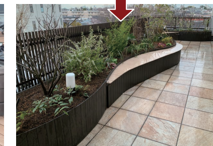
骨材はリプラ板材を使用しデッキ材張付け
