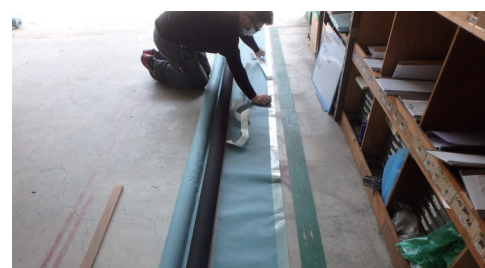
くるくすシートは両面テープ接着、ステン針止め
