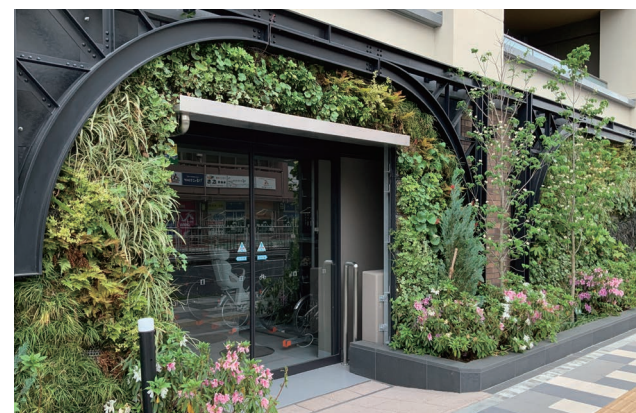
神奈川県横浜市金沢区 マンション壁面
