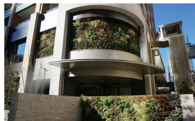
神奈川県川崎市 マンション壁面
