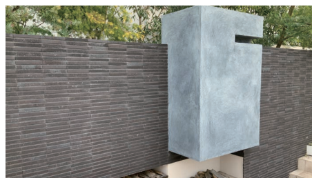
EPS壁(フェンス)
