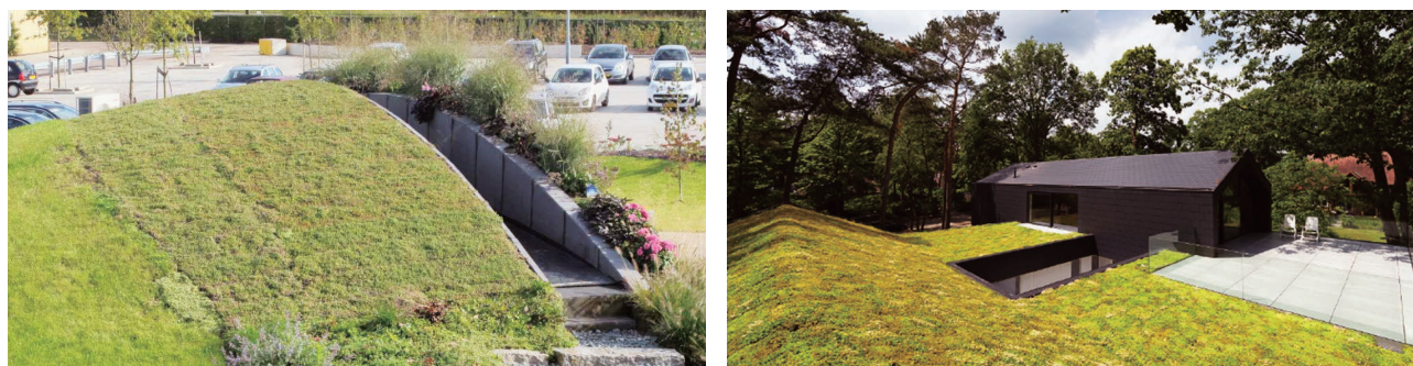
2013年5月 オランダ Venlo展示会パビリオン 120㎡ アルミ 合成防水処理 傾斜度30度 高さMax5m
