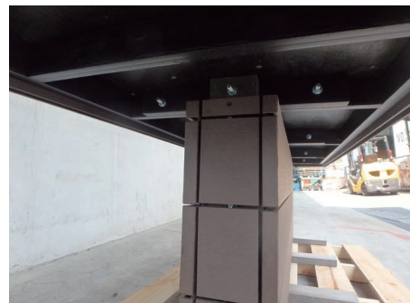
骨材は安価なリプラ角を使用しデッキ材張付け
