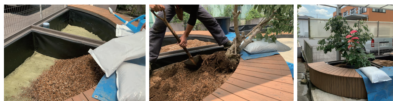
プランター内GRの上に土入れ
