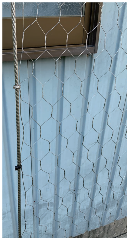
亀甲網・ワイヤー張り
