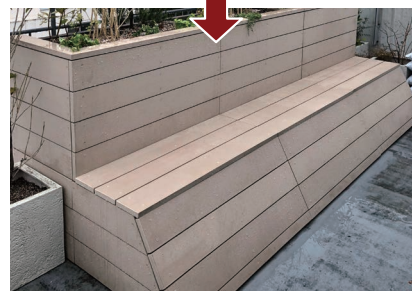
骨材はリプラ角材を使用しデッキ材張付け
