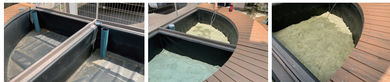
くるスト透水管を隅に設置
