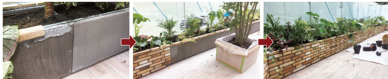
リプラ板の上にステンメッシュ張り
