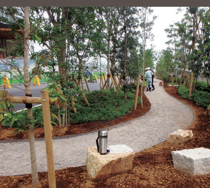
まさ土舗装 6mmエッジ 曲線使用
