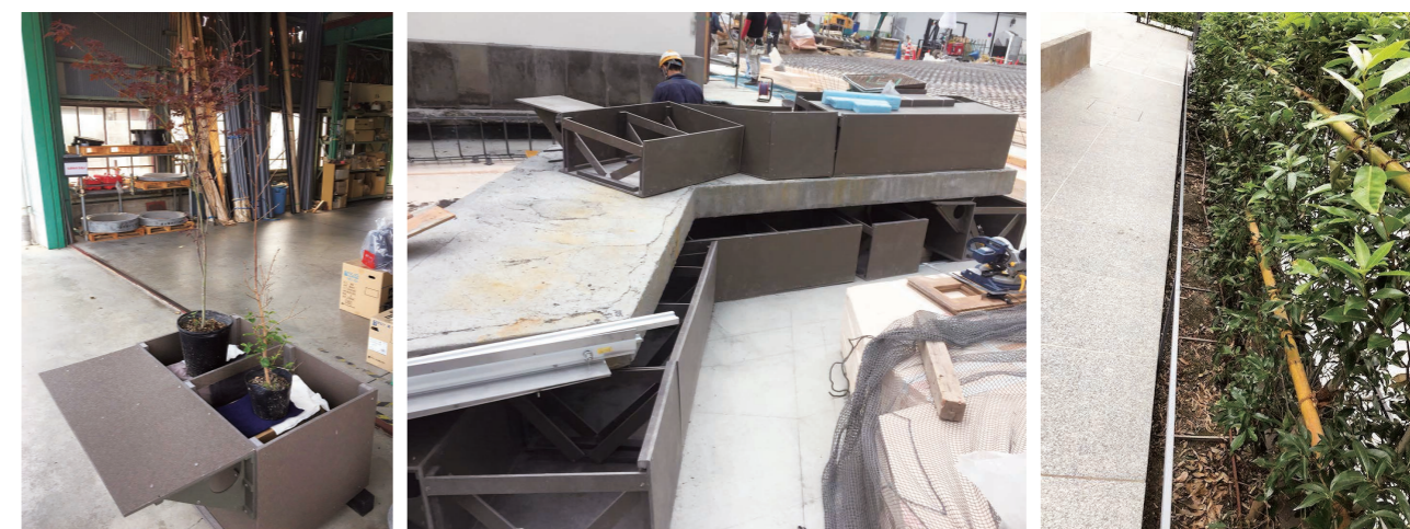
免震リプラfプランター-L900×D(600+450)×H540mm
