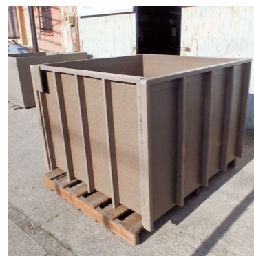
プランター側壁に角材補強
