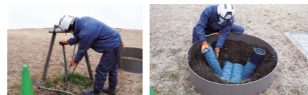
リプラ枠を設置
