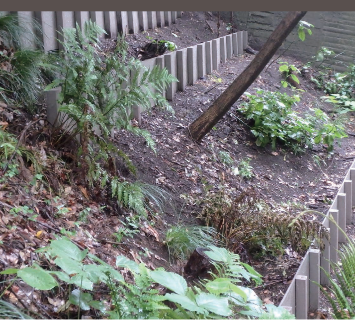
東京都国分寺市 傾斜地土流れ止め
