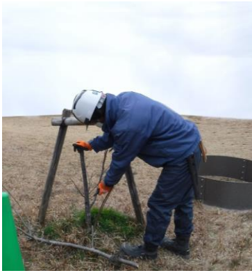
4mmt H20cmx 径 114cm リフレ枠設置
