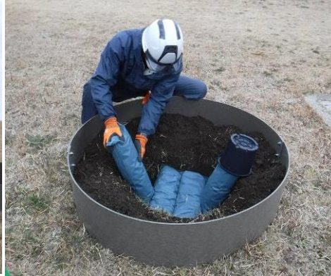
リフレ枠の中に土とくるスト酸素管を設置
