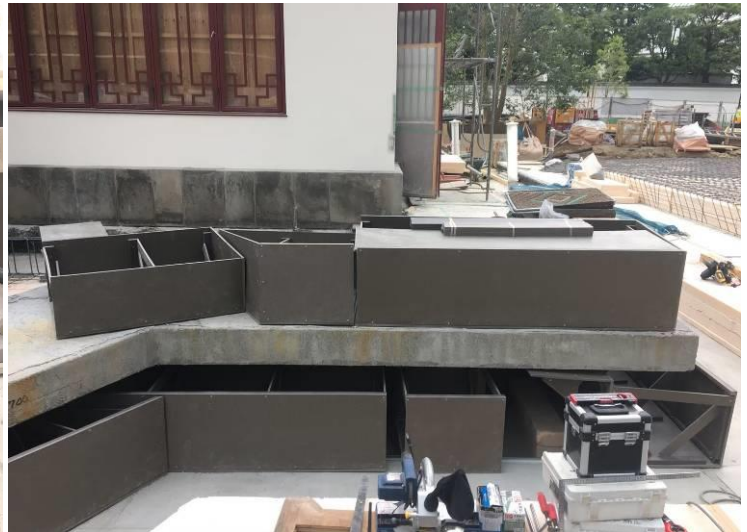
免震リフレフランター組立て施工途中
