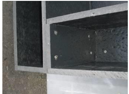
枕木コの字に沿わせて、次の枕木コの字を 載せ、側板をビスどめする
