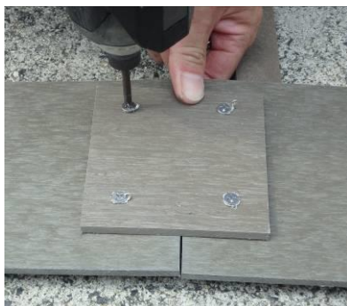
つなぎ板にステンビスを 4 本打込み
