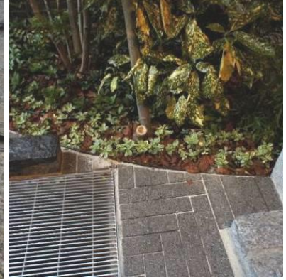
インターロッキング 4mm エッジ 曲線使用
