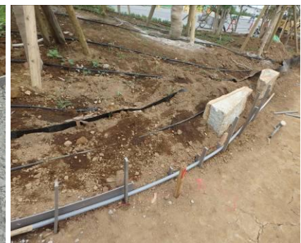
塩ビ管で墨出し。杭で仮止めする。
