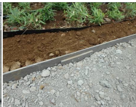
現場は長めのつなぎ板を使用
