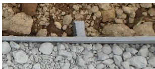
リフラ杭止め
