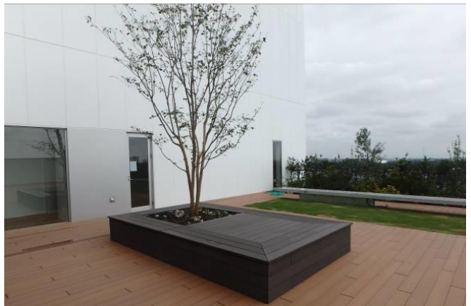
テッキ貼りベンチ内の大型プランター 埼玉県所沢市
