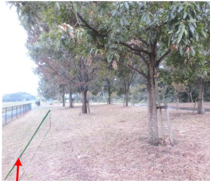
②の区域にくるストシートを埋設 樹木の根が遊歩道に出ないように 埼玉県河川防水センター2019年10月
