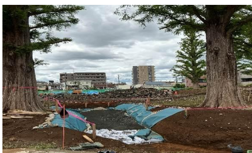
板橋区 板橋交通公園改築 溜れ沢 くるストシート+GR敷き 道路脇にくるストシート敷き 2026年5月
