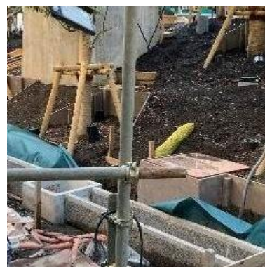
東京モノレール下の園路 くるストシートによる排水溝への根の侵入防止
