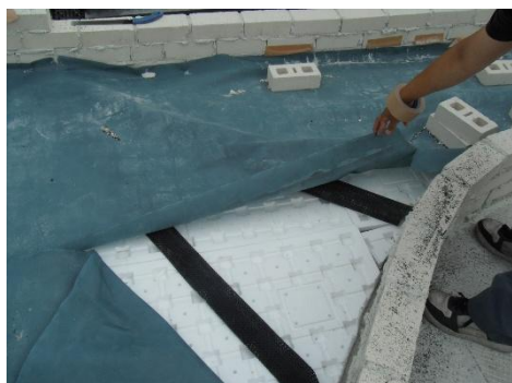
岐阜県屋上緑化 2014年5月施工
